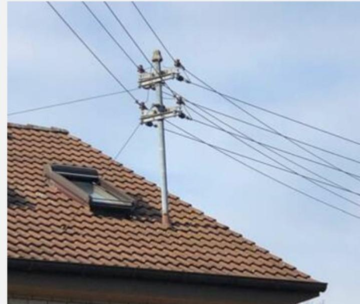
Antennen müssen immer von elektrischen Freileitungen entfernt sein. Sie dürfen solche elektrischen Leitungen unter keinen Umständen berühren, da sonst gefährlich hohe Spannungen in die Funkanlage gelangen können bzw. dass sich lose Drähte oder Teile in Kontakt kommen können.
